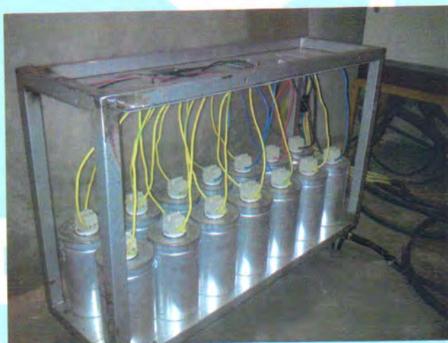
شکل (۴): بانک خازنی برای جبران جریان راکتیو
